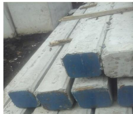
Gambar 6 tumpukan mini pile dilapangan
